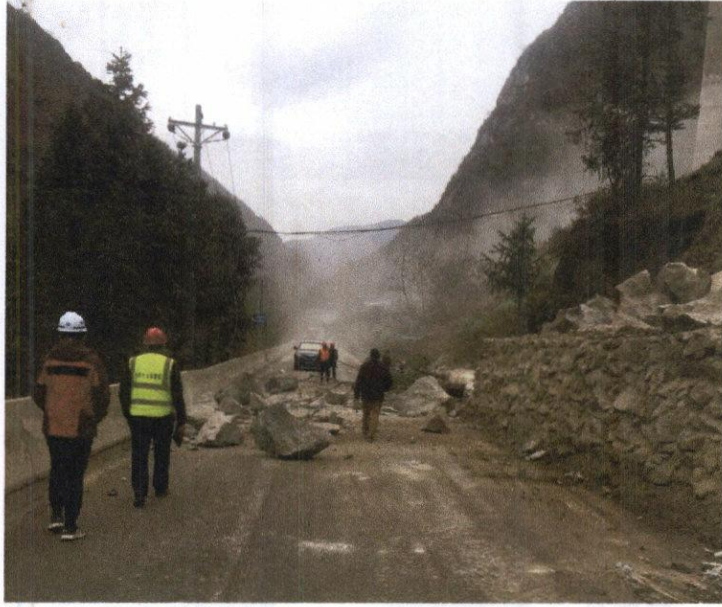
爆破作业现场人员值守
