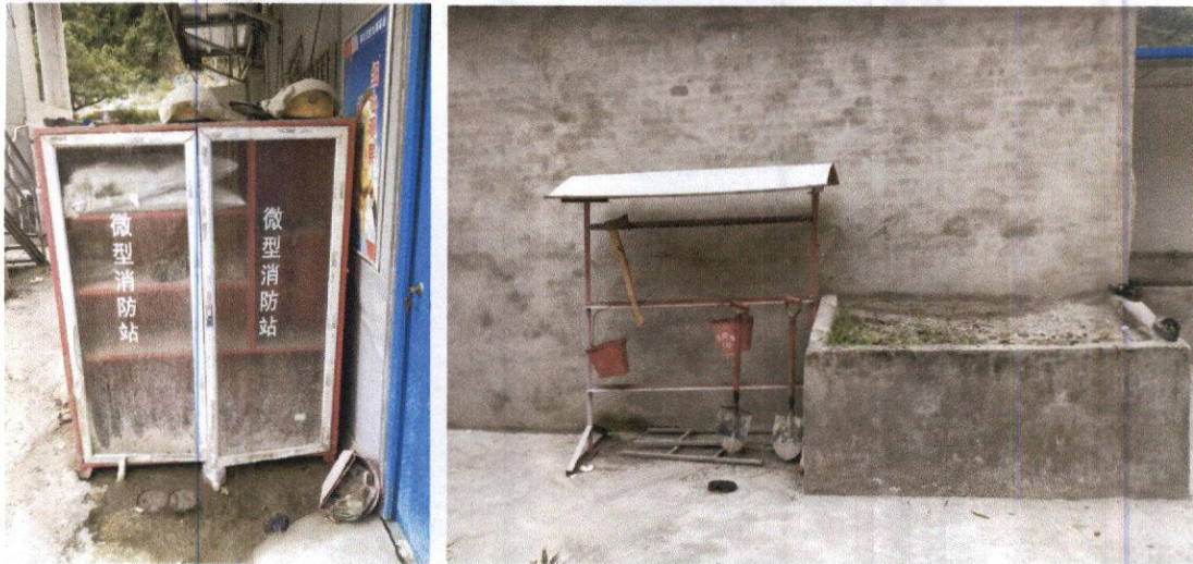
长春岭隧道进口施工现场微型消防站及消防沙池
